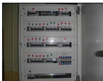
Cuadro eléctrico general
